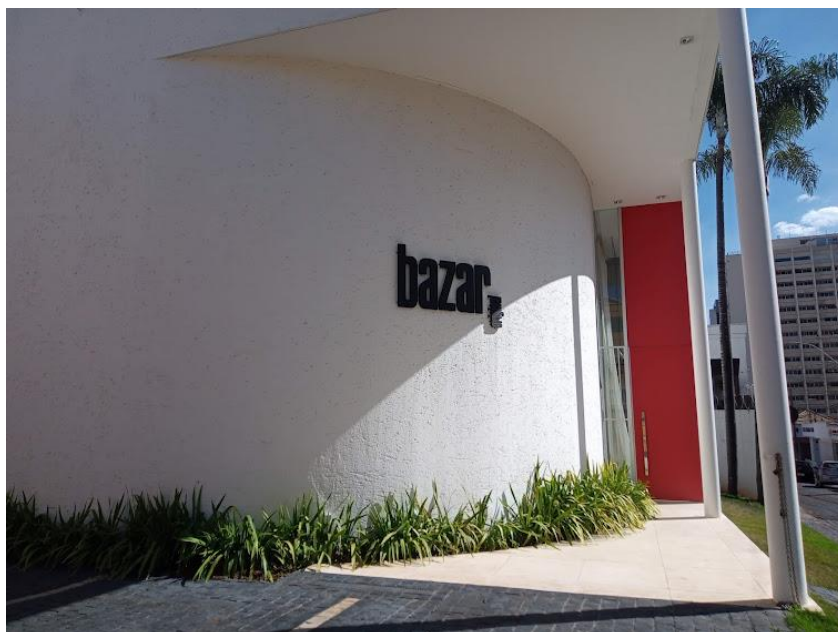
Figura 19: Fachada Bazar Original
