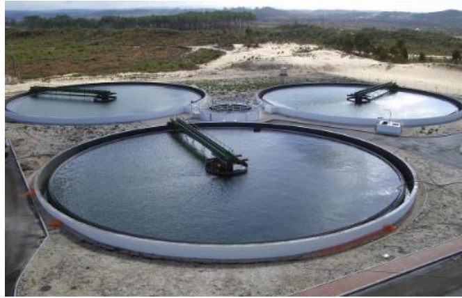
Figura 5 - Decantador circular com remoção de lodo mecanizada.
