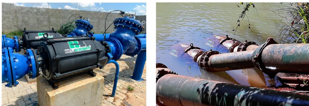
Figura 3 – Motobomba emersa (esq.) e motobomba imersa (dir.).
