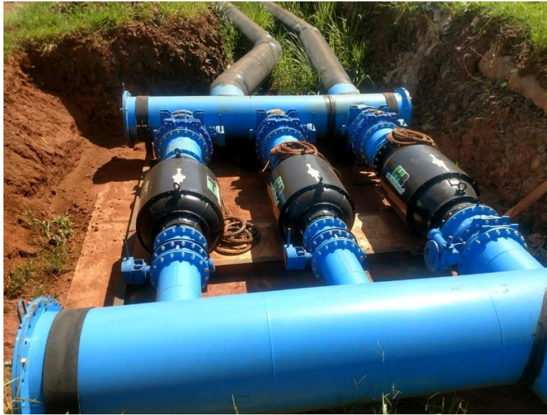
Figura 14 – Processo de instalação das motobombas concluído (I)
