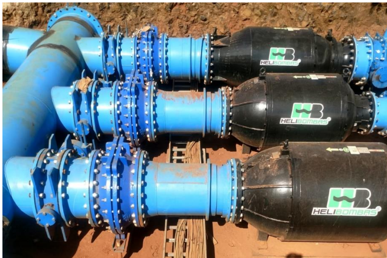
Figura 15 – Processo de instalação das motobombas concluído (II)
