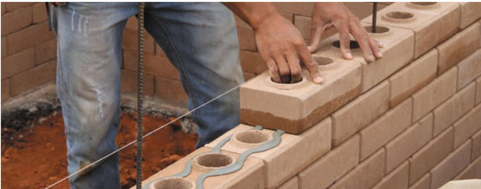
**Figura 75:** Construção com tijolo de solo-cimento
