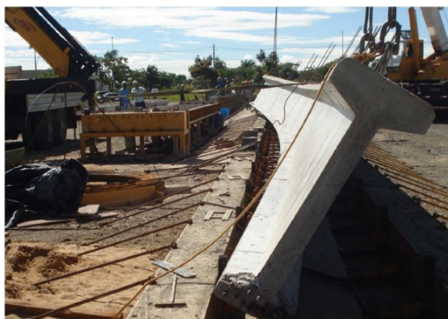
Figura 4 - Viga durante içamento em Uberlândia-MG
