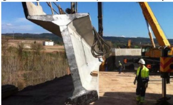
Figura 5 - Viga em processo de içamento em Olost, Espanha
