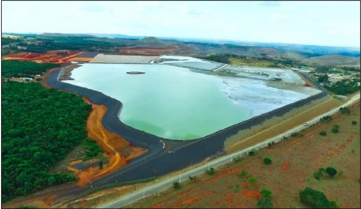
Figura 3 - Barragem de rejeitos CMOC (2018).
