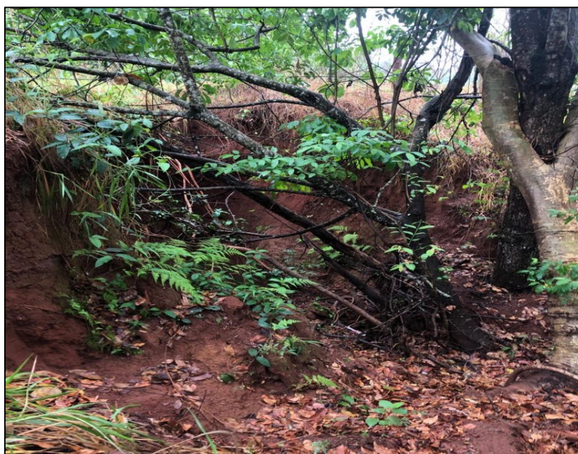
Figura 07 – Voçoroca localizada no interior do Parque do Goiabal.
