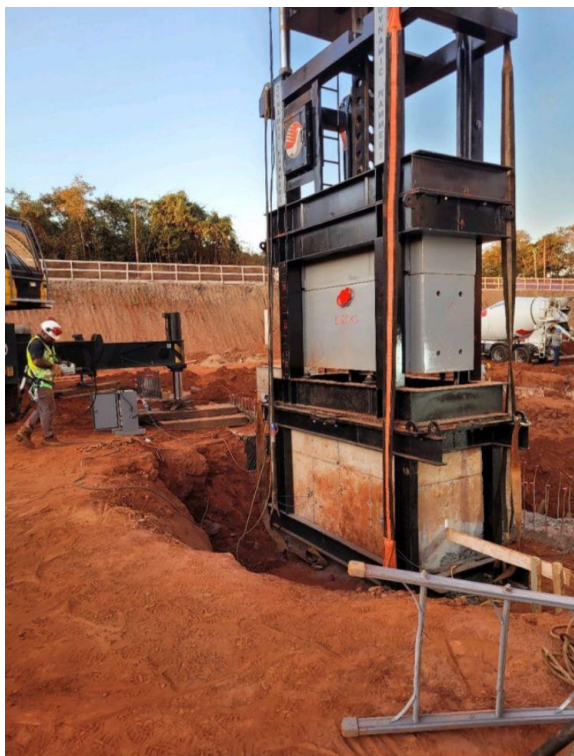
Figura 29 - Ensaio de carregamento dinâmico em estaca barrete (Autora, 2022)
