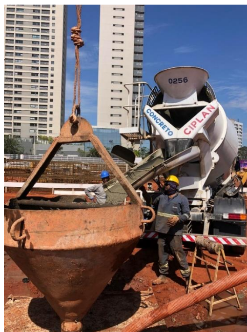
Figura 26 - Concretagem de estaca barrete (Autora, 2022)
