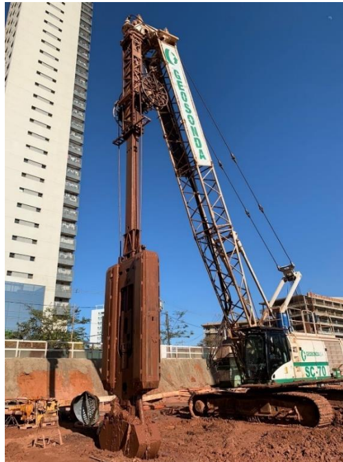
Figura 25 - Escavação de estaca barrete
