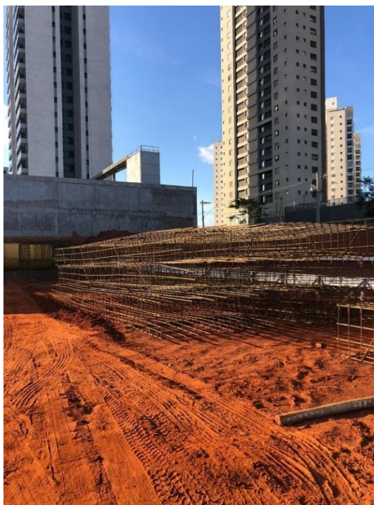
Figura 18 - Armações das estacas barrete (Autora, 2022)
