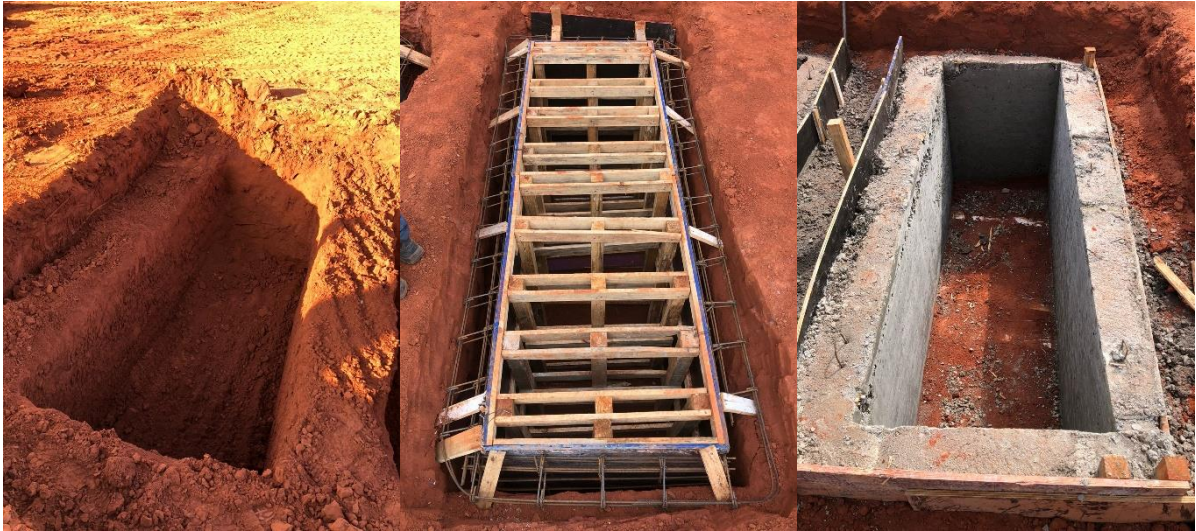
Figura 4 - Etapas de execução da mureta-guia (Autora, 2022)
