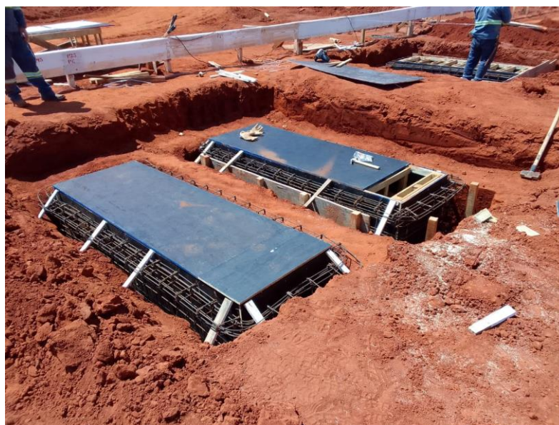
Figura 24 – Execução da Mureta-guia (Autora, 2022)
