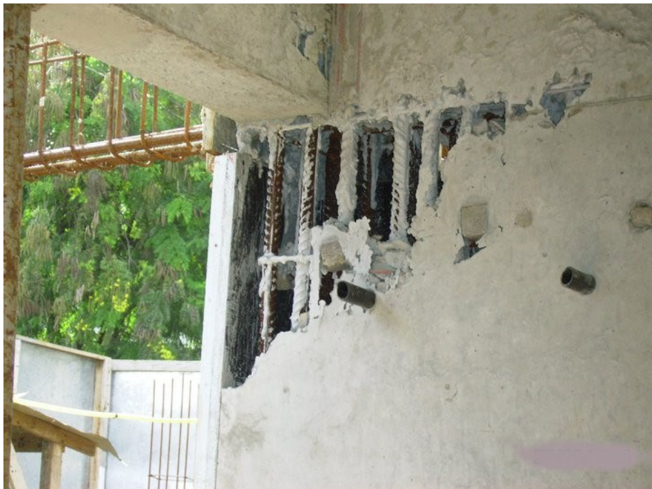
Figura 7: Nichos de concretagem
