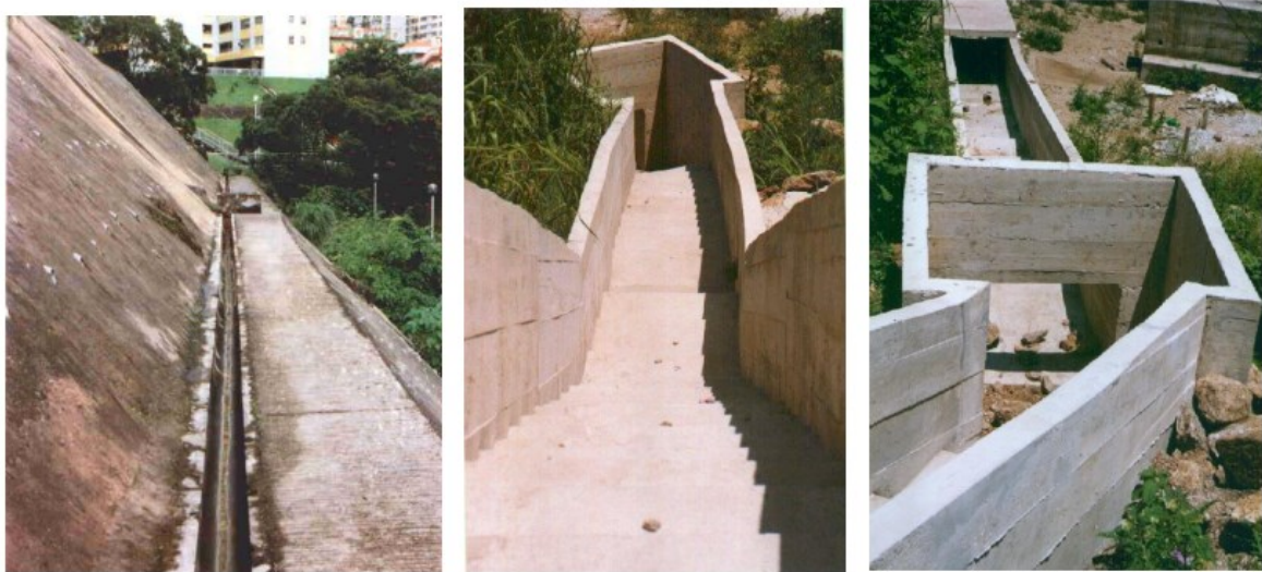
(a) Canaleta transversal
