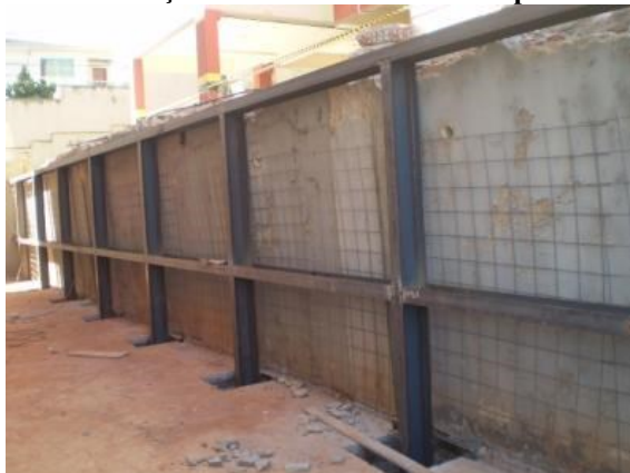
Figura 12: Reforço em muro de arrimo com perfil metálico
