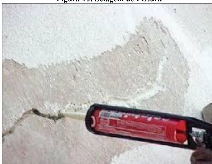
Figura 10: Selagem de Fissura
