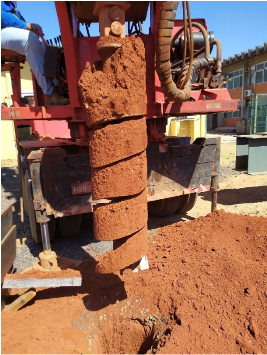
Figura 50. Escavação das estacas de reação.
