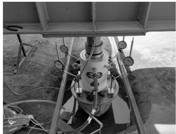
Figura 67. Prova de carga em estaca isolada condição inundada ES-EXP-INUND.
