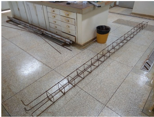
Figura 60. Confeção da armadura das estacas.
