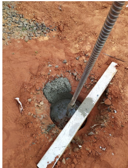
Figura 53. Tirante posicionado após a concretagem da estaca de reação.
