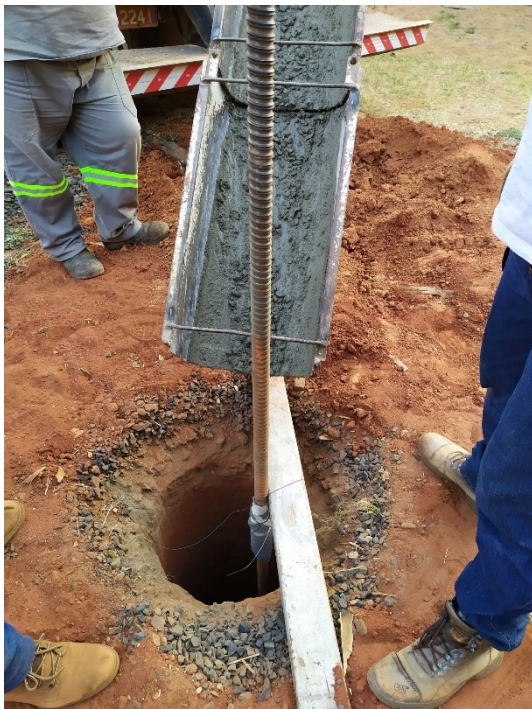
Figura 52. Posicionamento do tirante no furo antes da concretagem.
