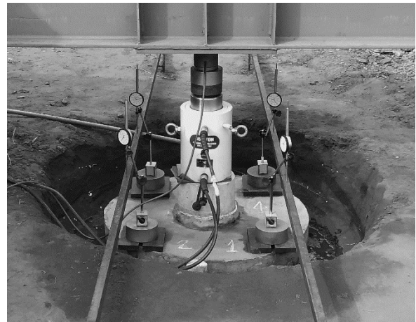
Figura 65. Prova de carga em sapata isolada condição inundada SP-EXP-INUND.
