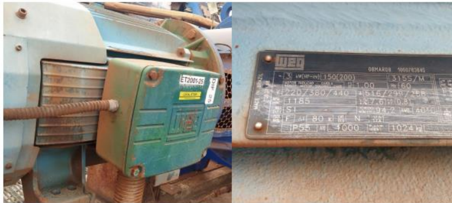
Figura 13- Motor elétrico e plaqueta de dados
