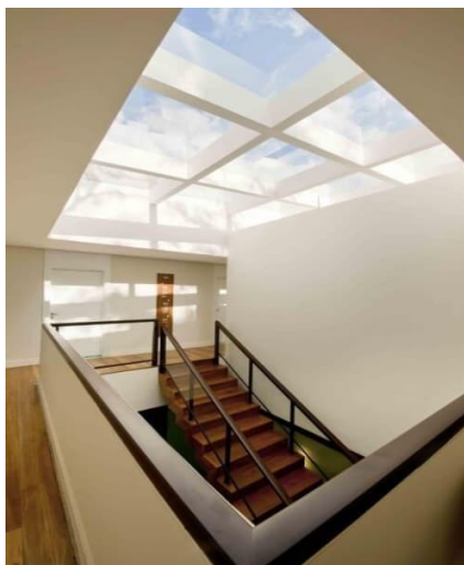
Figura 9: Claraboia em Edificação
