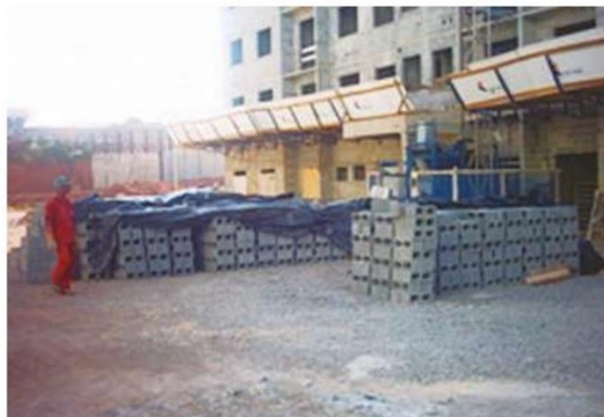
Figura 7 – Empilhamento de blocos de concreto
