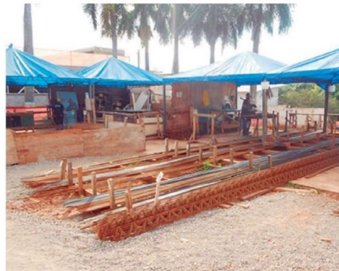
Figura 8 – Feixes com vergalhões e armaduras
