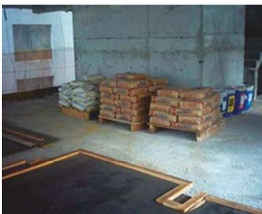
Figura 5 – Sacarias de cimento estocadas sobre paletes
