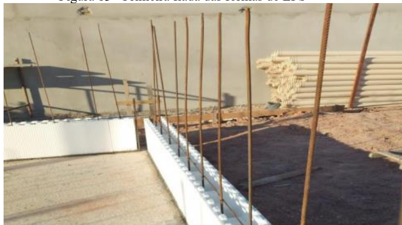
Figura 13 - Primeira fiada das fôrmas de EPS
