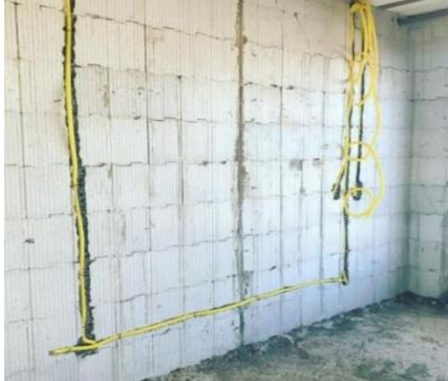
Figura 14 - Instalação nas fôrmas de EPS
