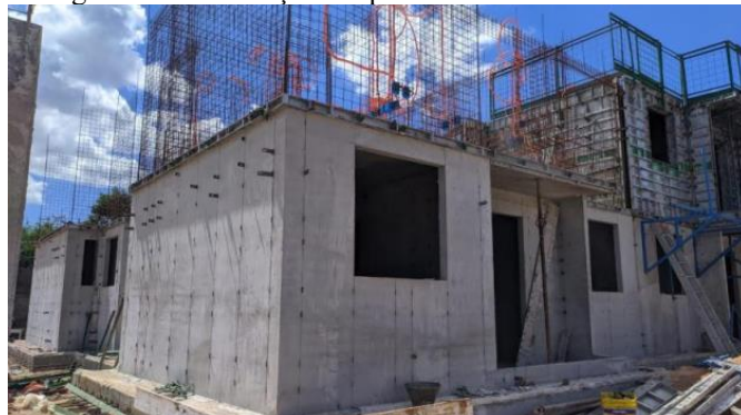
Figura 01 – Edificação em paredes de concreto
