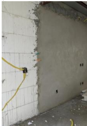
Figura 15 - Parede do sistema ICF sendo revestida
