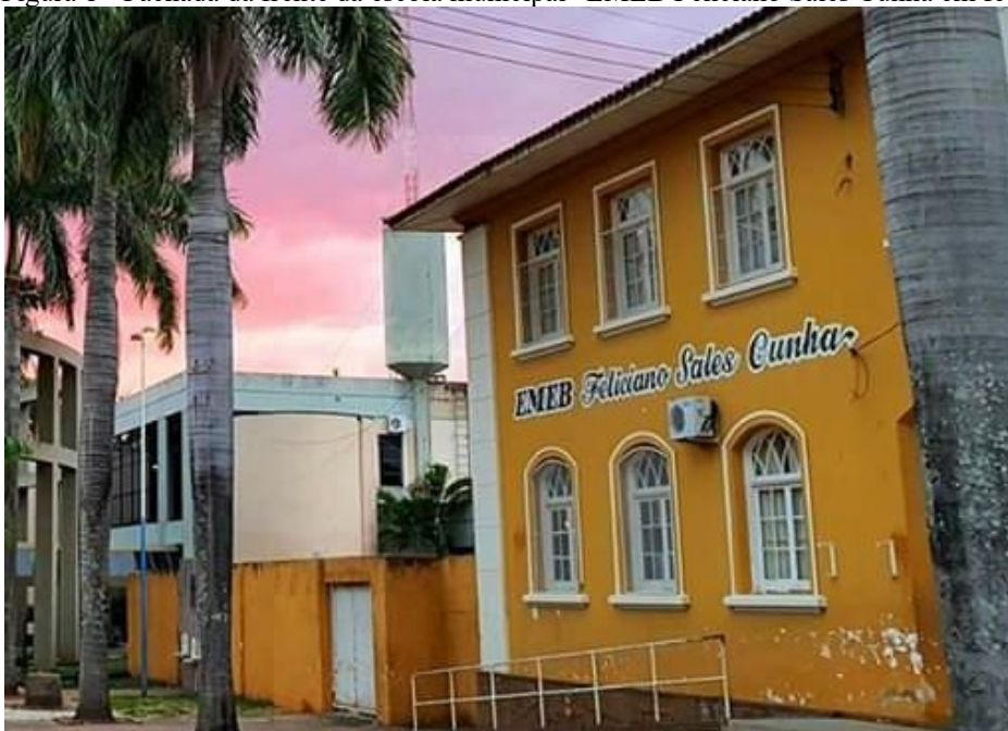
Figura 1 - Fachada da frente da escola municipal “EMEB Feliciano Sales Cunha em fevereiro de 2022”.
