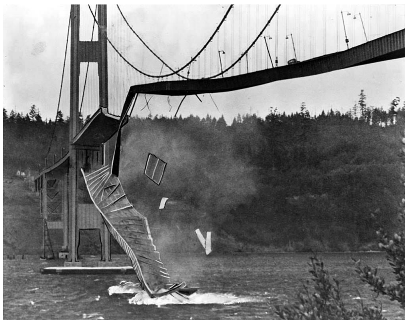
Figura 1 – Exemplo de falha catastrófica da Ponte de Tacoma
