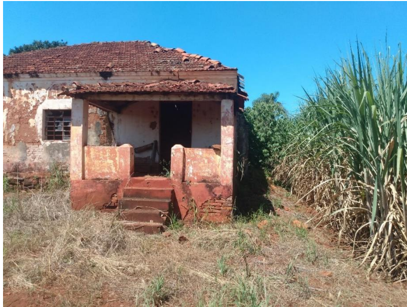
Figura 26 – Casa de colono abandonada.
