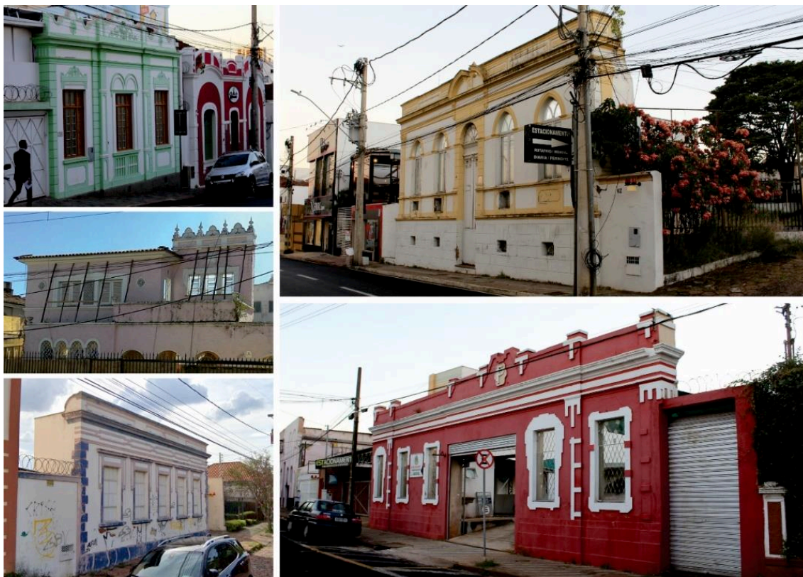
Figura 27 – Exemplo de imóveis em que apenas a face frontal foi preservada 56
