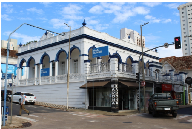
Solar dos Mendes - Rua São Sebastião, 01
