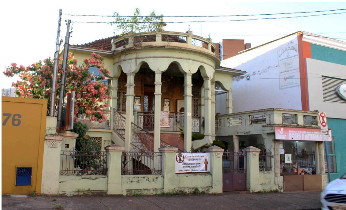
Figura 32 - imóvel situado na Rua Senador Pena, n. 352, em estado precário de conservação
