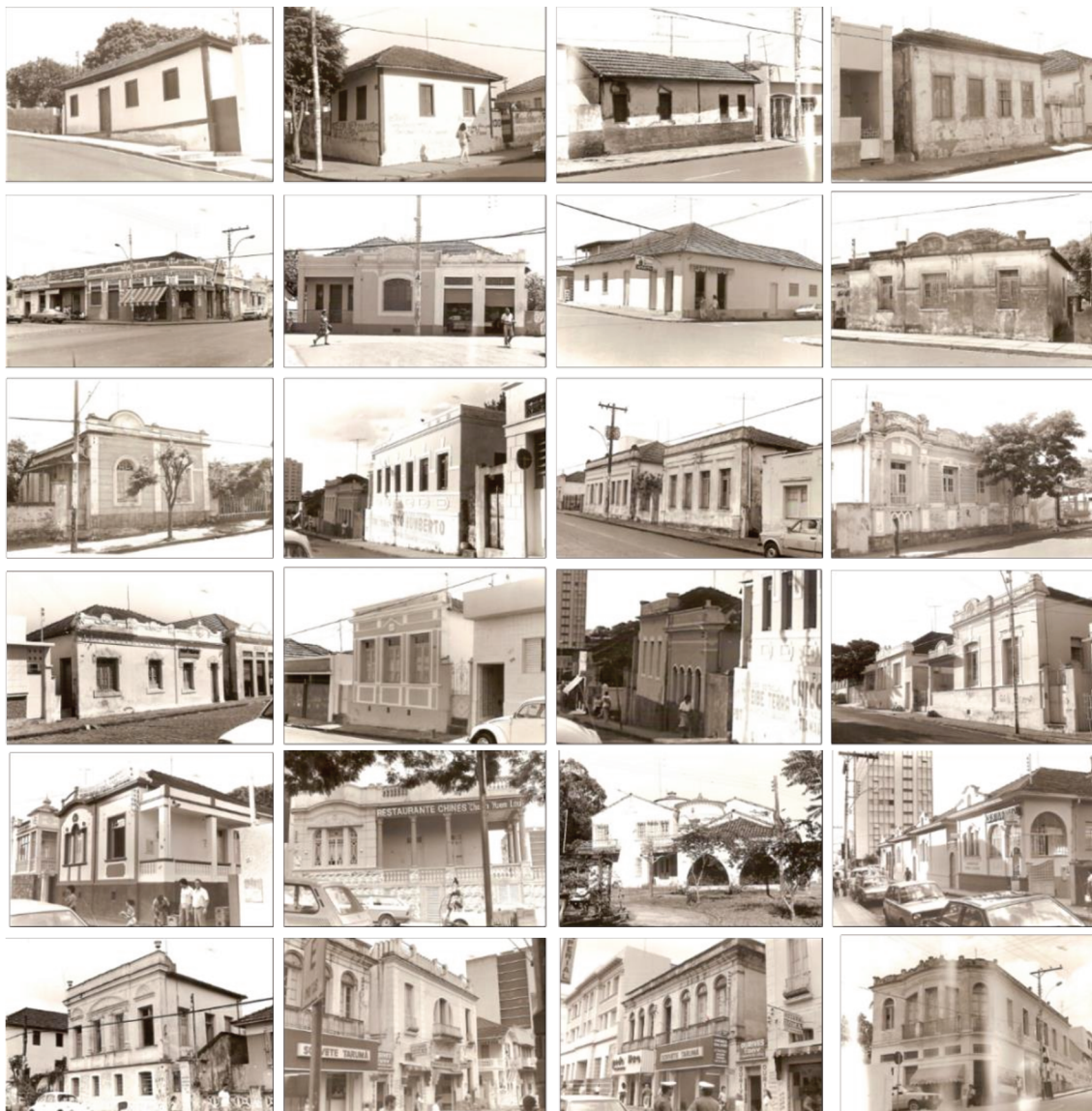
Figura 25 - Imóveis inventariados cuja demolição não consta em ata do Conselho 52
