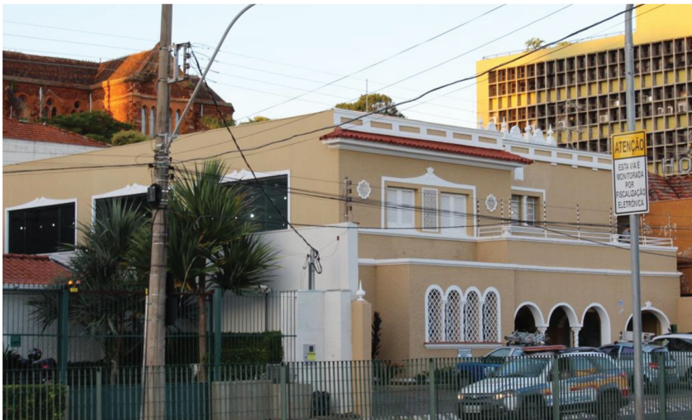
Figura 49 - Imóvel da Av. Leopoldino de Oliveira, n. 3294, após construção do novo corpo
