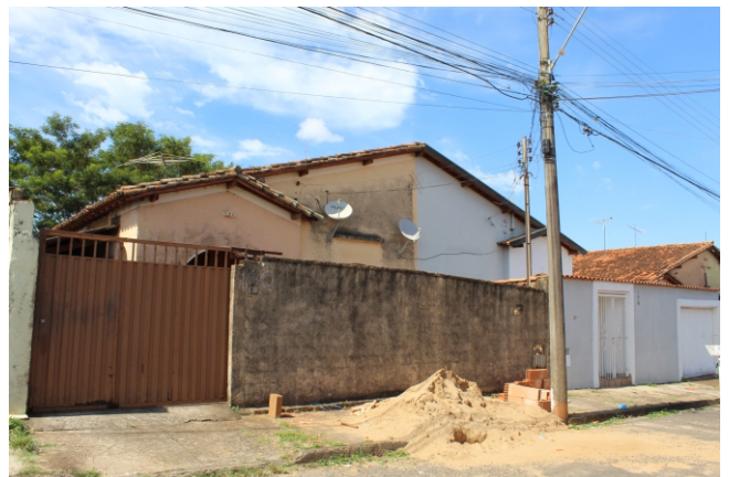
Rua dos Ferroviários, 106, 110
