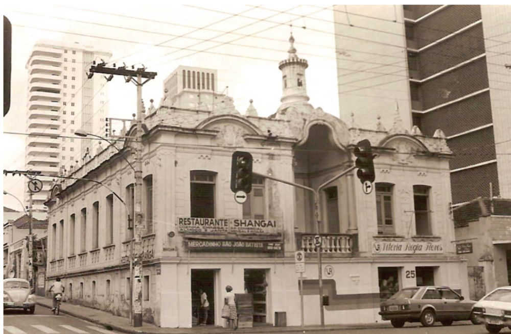
Figura 41 - Palacete Pedro Naves, demolido após a aprovação do tombamento compulsório
