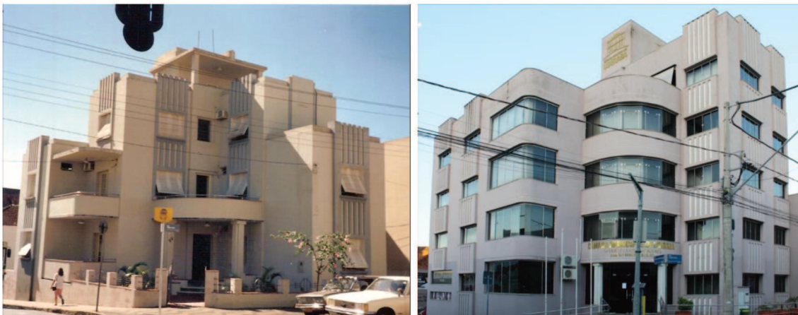
Figura 29 – Descaracterização de imóvel Art' Déco situado na Rua Vigário Silva, n. 143
