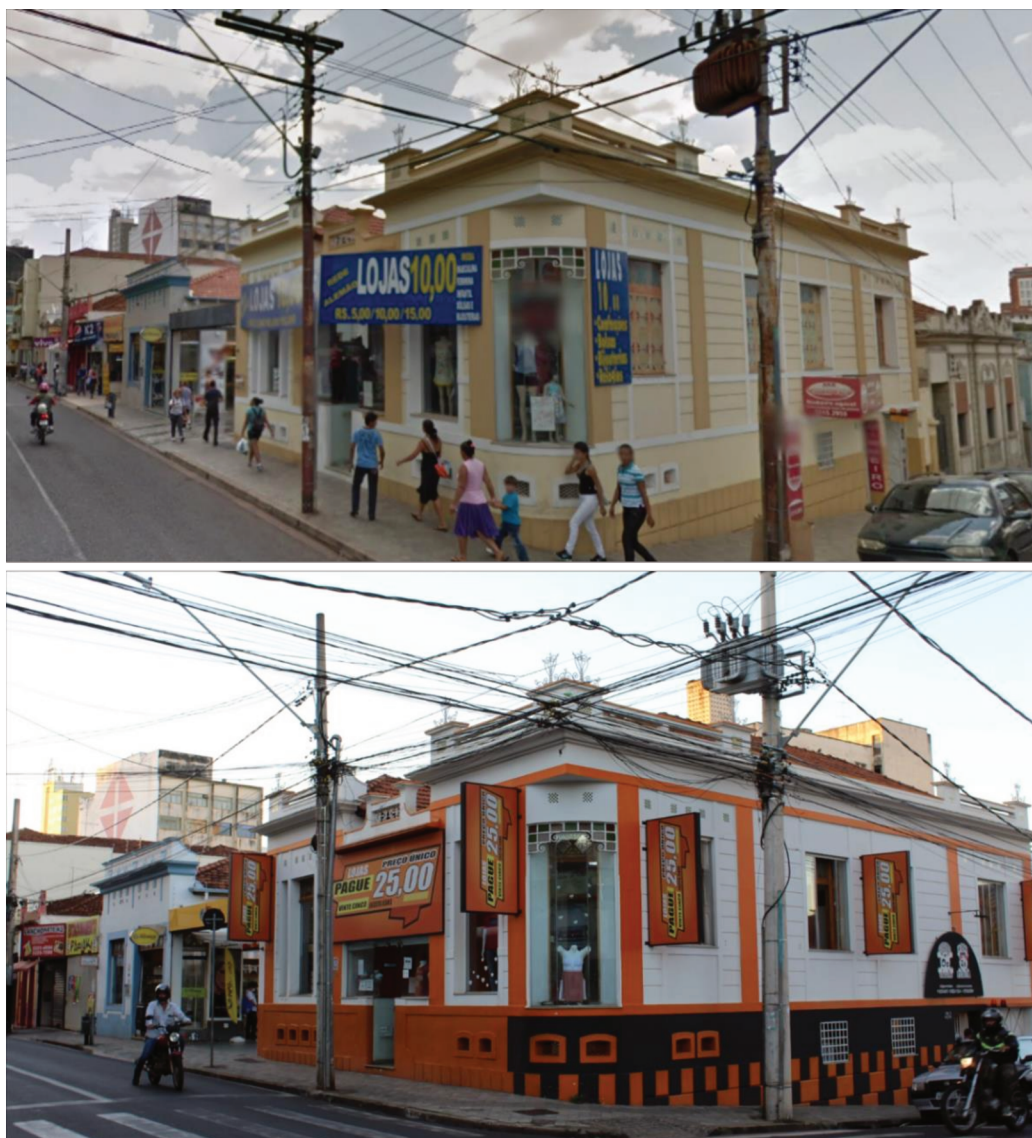
Figura 35 - Aumento do volume do cabeamento aéreo em dez anos. Exemplo do imóvel tombado situado na Rua Vigário Silva, n. 119, em 2011 (imagem superior) e 2021, parcialmente ocultado pela poluição visual
