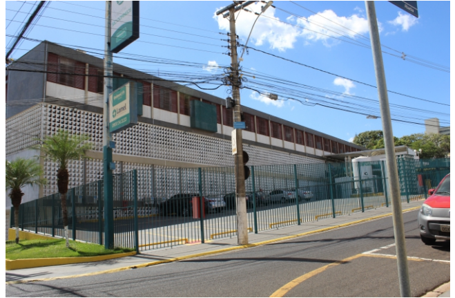
Hospital São Domingos
