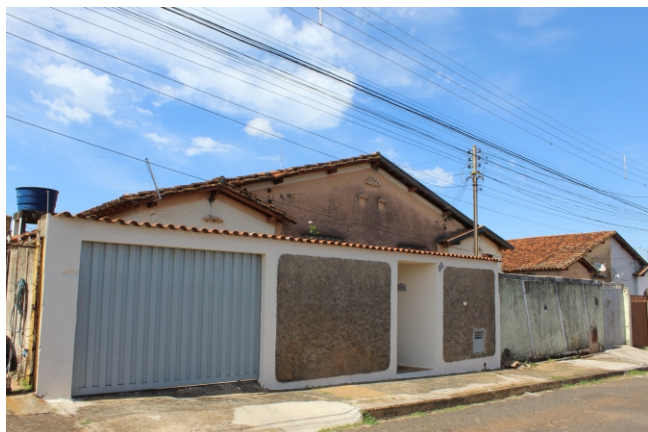
Rua dos Ferroviários, 118, 132
