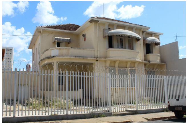
Rua Capitão Domingos, 180
