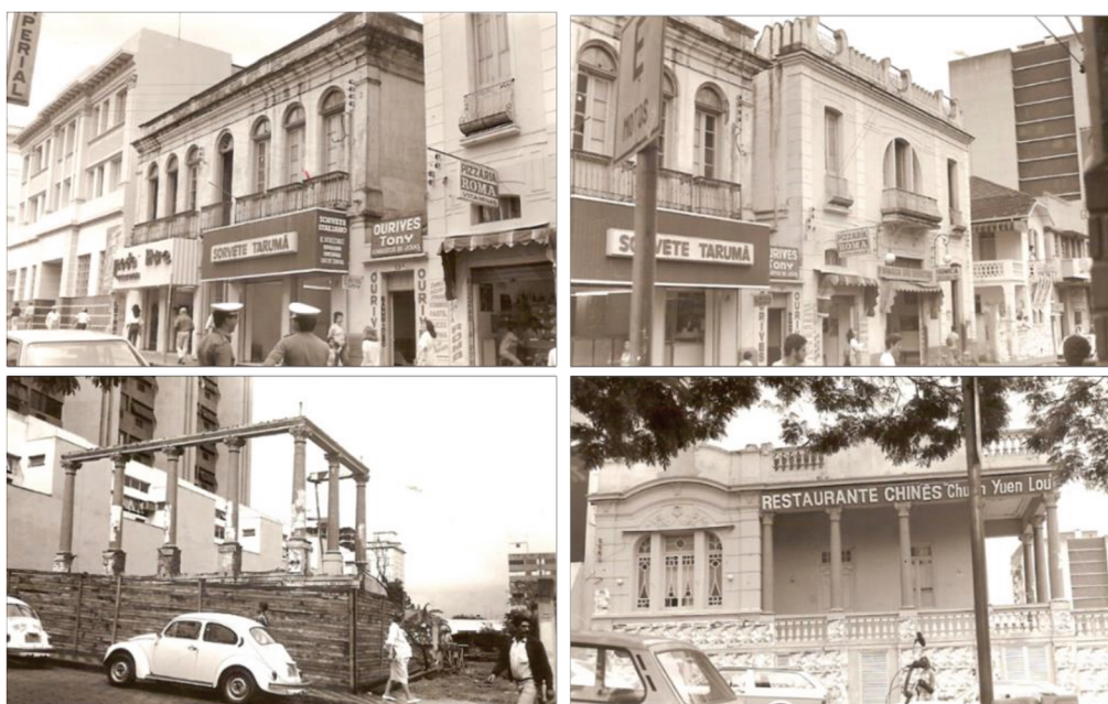
Figura 15 – Da esquerda para a direita, em sentido horário, o sobrado da Rua Cel. Manoel Borges, n. 57; o sobrado da Rua Cel. Manoel Borges, n. 79; e a Residência da Praça Rui Barbosa, n. 258, antes e depois da demolição em 1988
