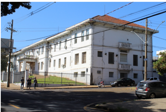
Santa Casa de Misericórdia
