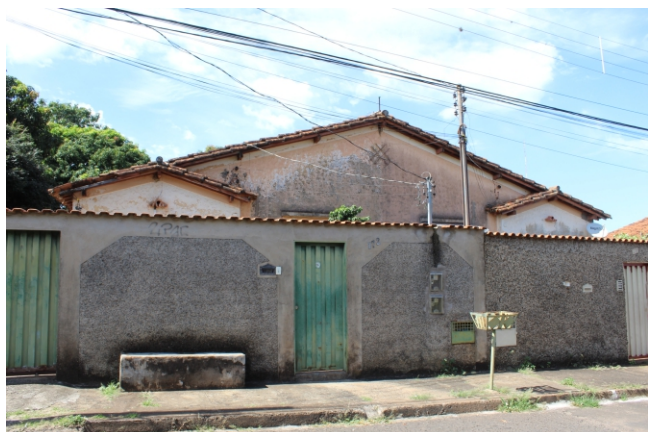
Rua dos Ferroviários, 160, 172
