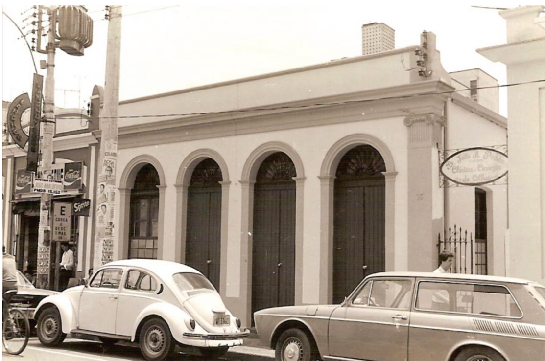
Figura 39 - Imóvel da Rua Vigário Silva, n. 95, demolido sem a apreciação do Conselho
