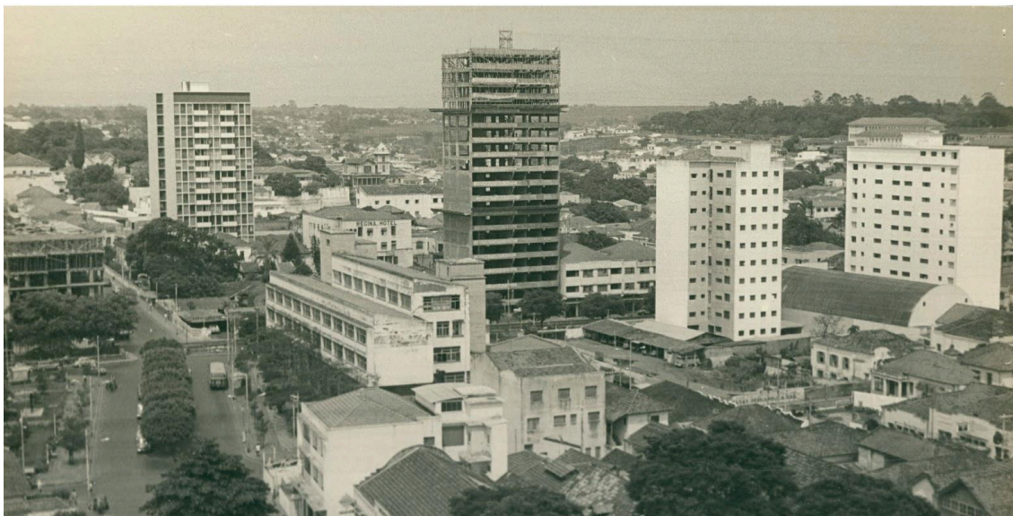
Figura 5 - Vista panorâmica - Av. Dr. Fidelis Reis com Av. Leopoldino de Oliveira. Ao centro, construção do edifício Rio das Pedras
