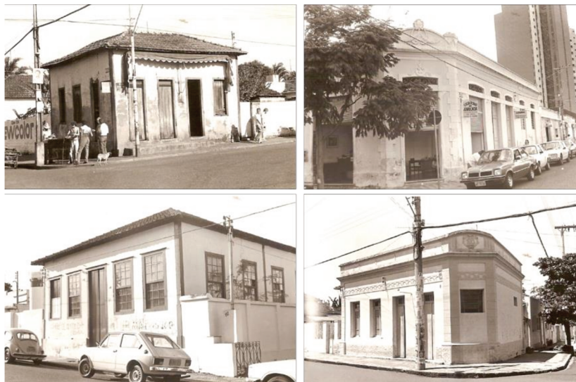
Figura 23 – Demolições autorizadas pelo Conselho, da esquerda para direita, em sentido horário: Rua José de Alencar, n. 76; Rua Senador Pena, n. 44; Rua Carlos R. Cunha, n. 191; Rua Padre Zeferino, n. 221
