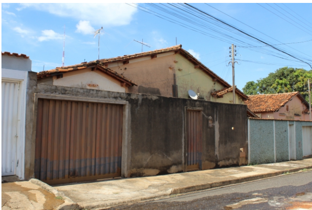
Rua dos Ferroviários, 88, 92
