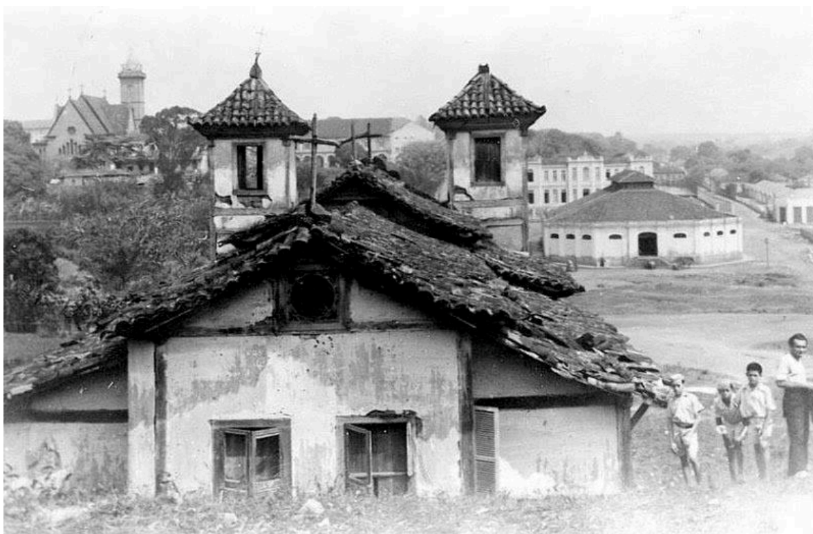
Figura 7 – Face posterior da Igreja de Santa Rita em processo de arruinamento; ao fundo o Mercado Municipal (1924) e a penitenciária (1910) e, à esquerda, a capela do Colégio Nossa Senhora das Dores, construída em estilo neorromânico (1930)
