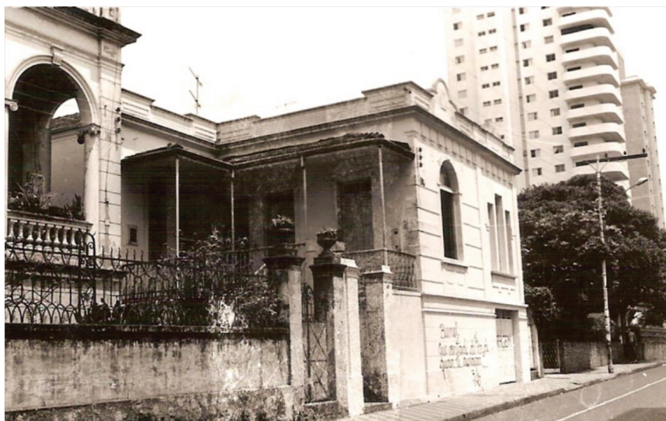
Figura 40 - Imóvel da Rua São Sebastião, n. 31, demolido sem a apreciação do Conselho
