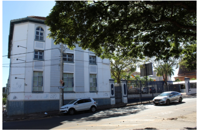
Pavilhão Original do Colégio Nossa Senhora das Dores
