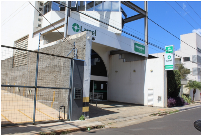
Rua Capitão Domingos, 383
