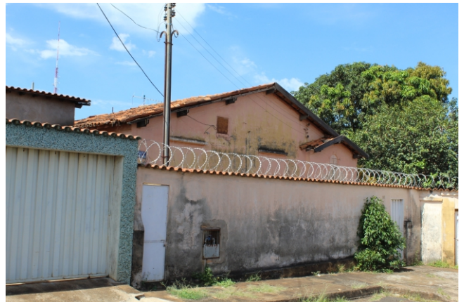
Rua dos Ferroviários, 76
