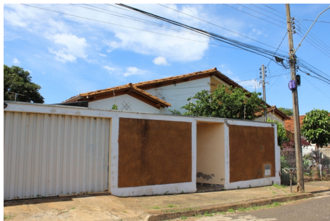
Rua dos Ferroviários, 148, 154
