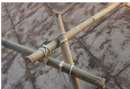
Imagem 62:Foto do detalhe do intertravamento entre as peças de bambu, ainda feitos com corda. Fonte: Acervo Por uma Clínica-Poética.
