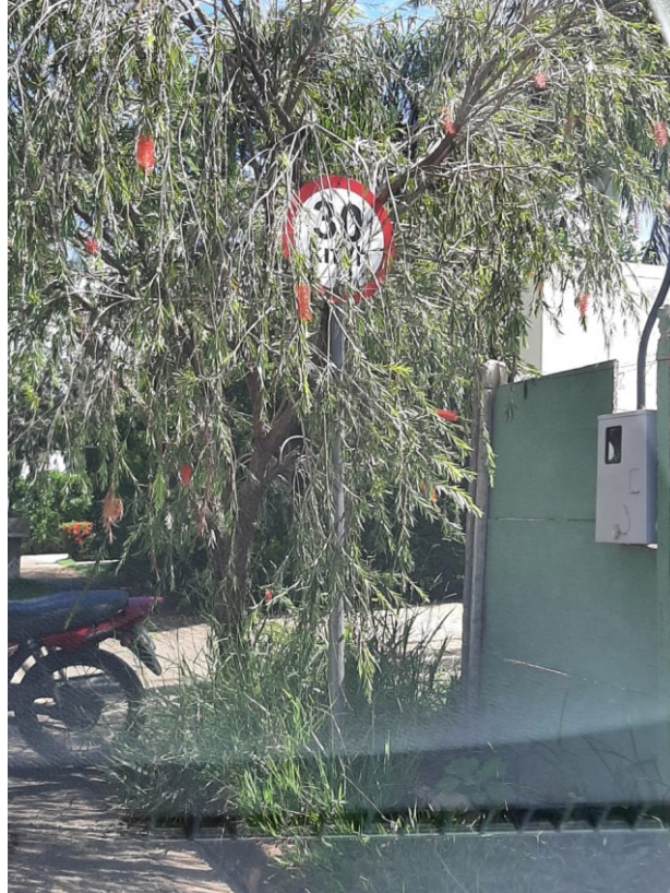
Figura 13 – Sinalização vertical obstruída por árvore
