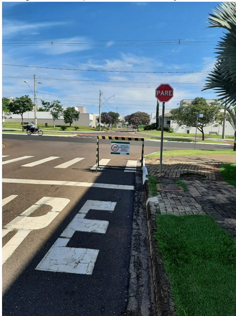
Figura 12 – Sinalização móvel com difícil leitura para motoristas
