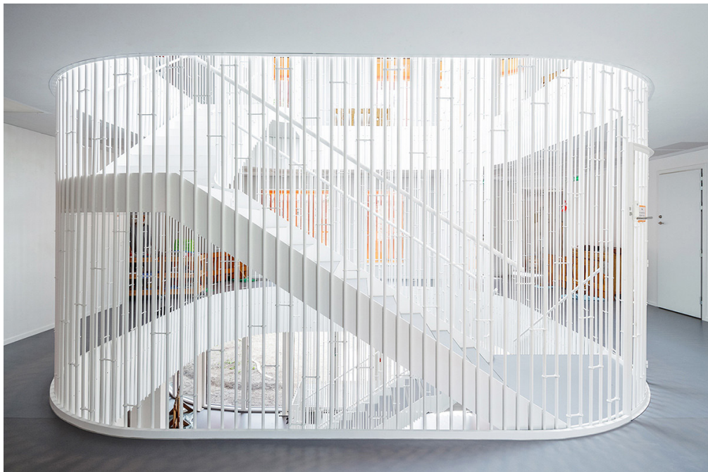
Figura 25: Moldura metálica da escada.
