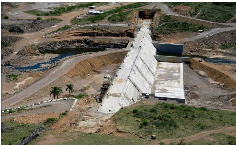
Figura 33 – Obras da barragem do arroio Tacuarembó, em janeiro de 2020
