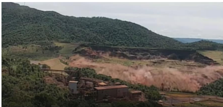
Figura 20 - Imagem do rompimento da barragem de Brumadinho.
