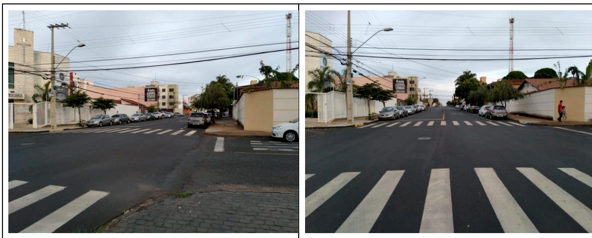
Figura 45: Interseção na rua Dr. Laerte Vieira Gonçalves (LVG).
