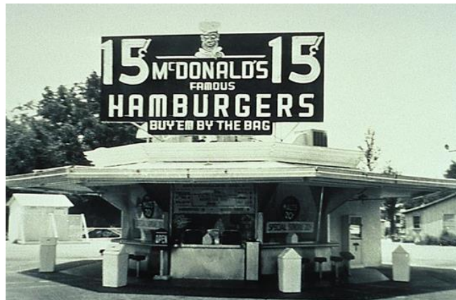
Figura 11 – Primeira fachada do McDonald's em 1948 (San Bernadino, California, EUA)
