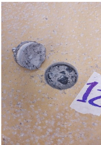
Figura 10 – Teste de Arrancamento realizado pela fabricante
