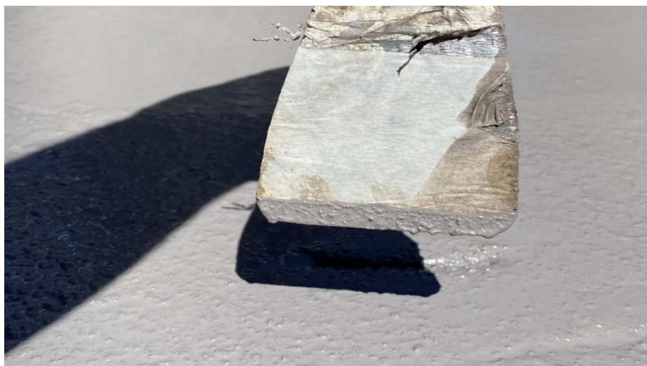
Figura 21 - Conferência da espessura da resina uretânica
