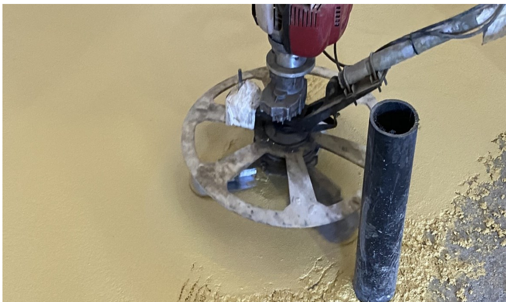
Figura 23 – Finalização do piso realizado com a máquina alisadora
