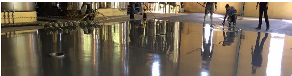
Figura 3 – Exemplo de piso uretano autonivelante no setor industrial
