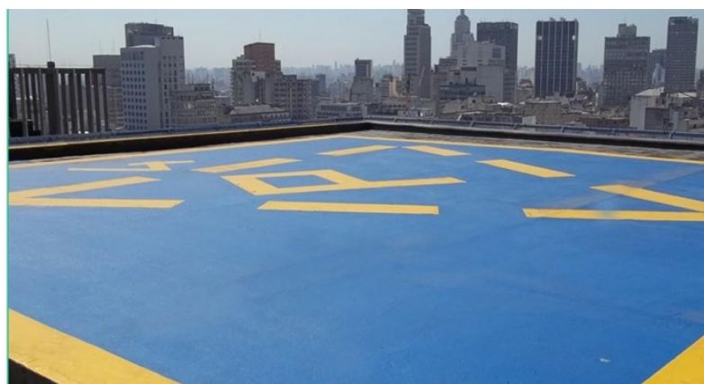
Figura 6 – Impermeabilização de uma laje de cobertura com poliuretano
