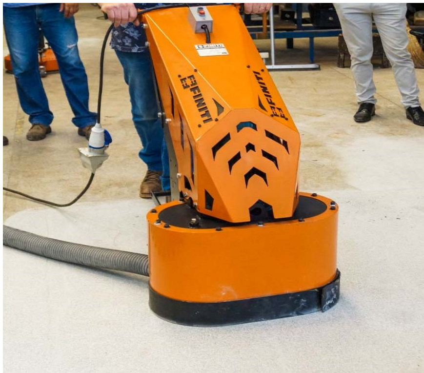
Figura 17 – Fresagem do piso com o equipamento politriz
