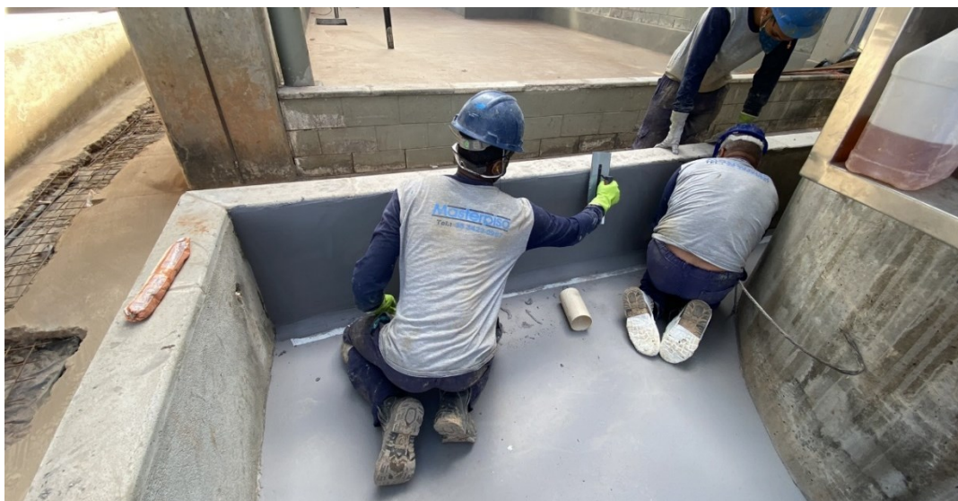
Figura 27 - Aplicação da resina uretânica nas muretas
