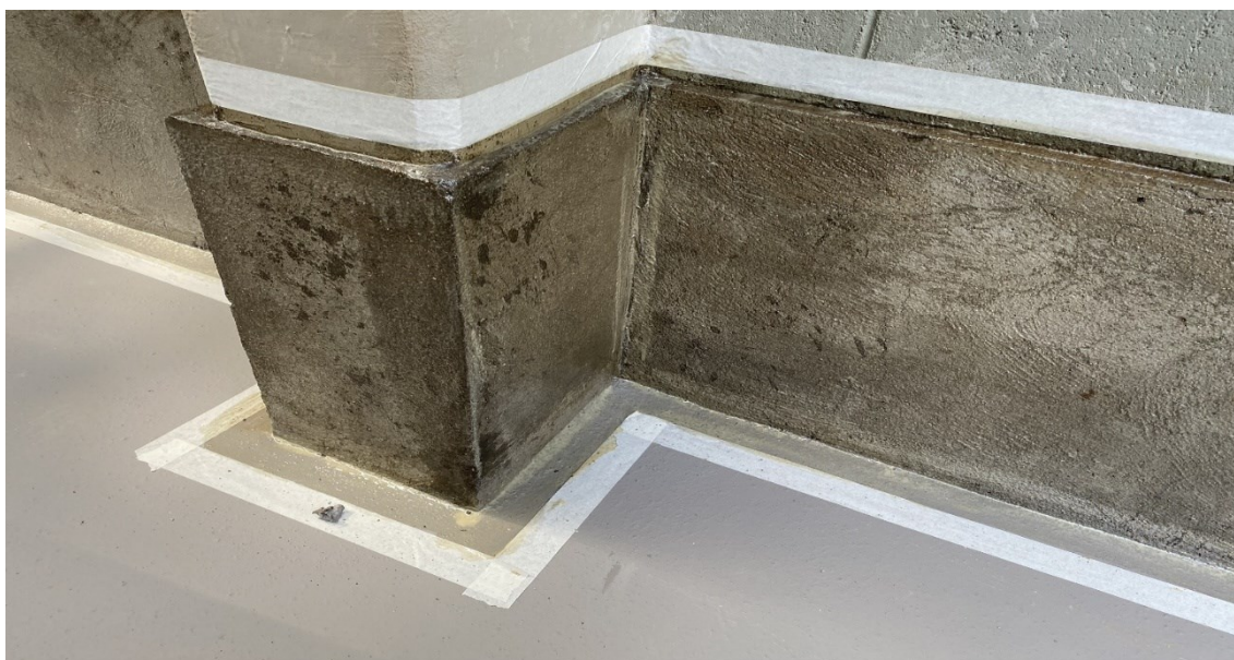
Figura 16 – Emprego do prime em muretas para iniciar a aplicação
