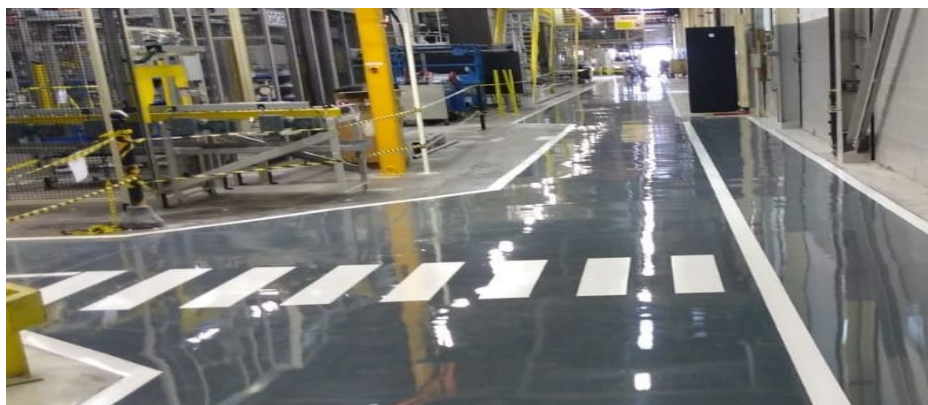
Figura 4 - Exemplo de piso uretânico no setor industrial.
