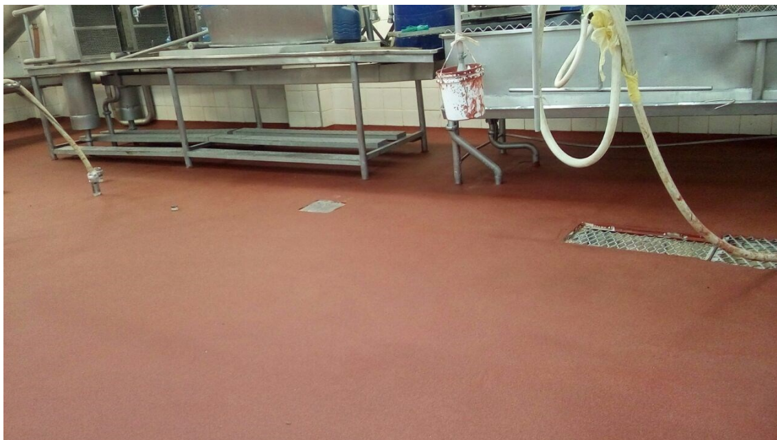
Figura 2 – Exemplo de piso uretano na indústria alimentícia
