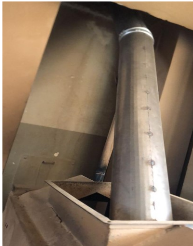
Figura 5 – Tubulação substituída em aço carbono e utilizando sistema de abraçadeiras.
