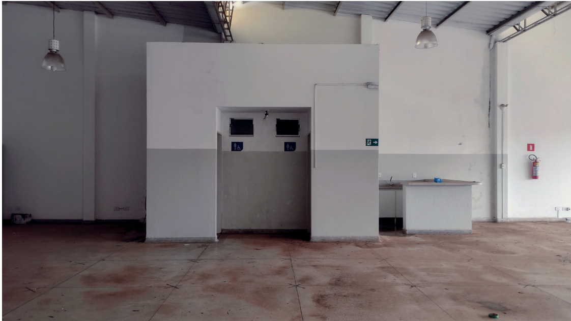
Imagem 43: Interior de Galpão: Lado direito.
