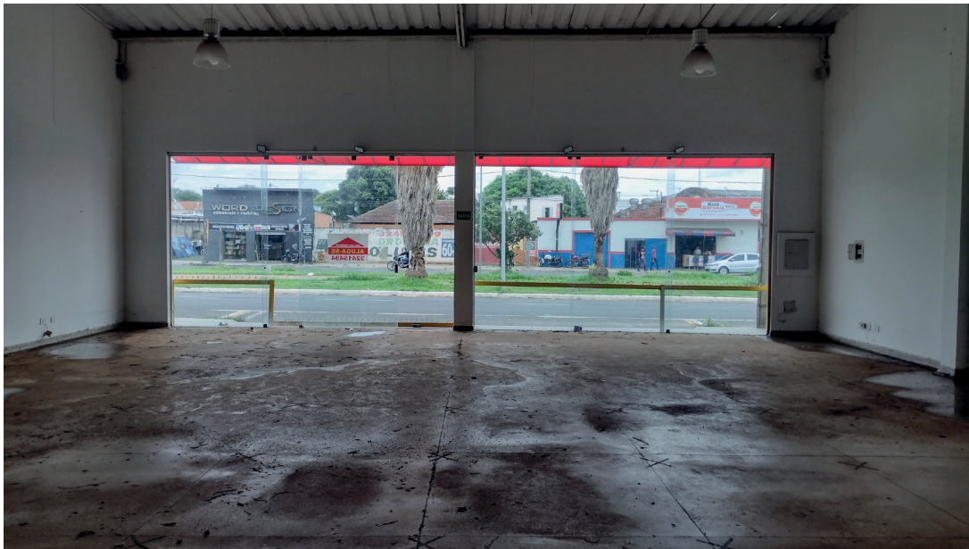
Imagem 41: Interior de Galpão: Frente.
