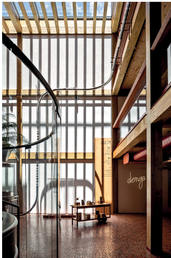
Imagem 21: Passagem de dutos e andar interligado
