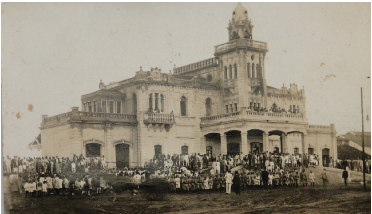
Figura 2: Prédio da Estação da Estrada de Ferro Goiás na inauguração (1928). Fonte: Arquivo Público Municipal e Museu "Dr. Calil Porto".
