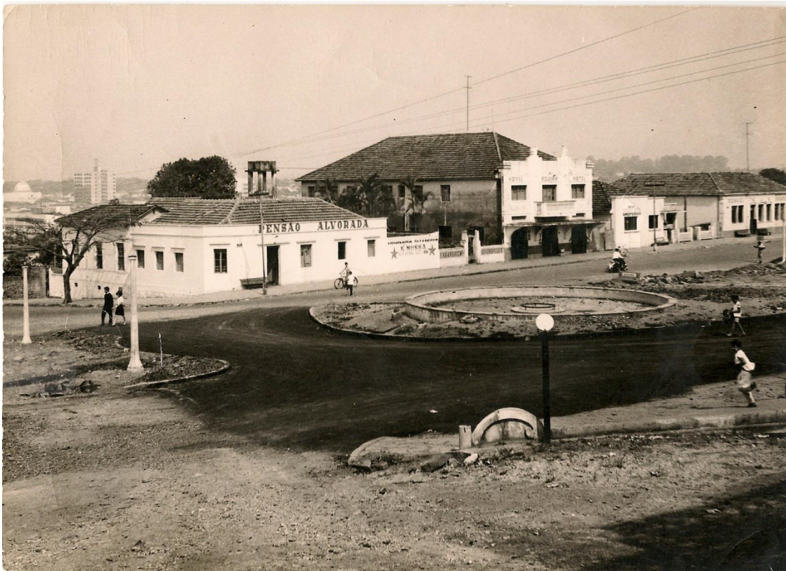
Figura 28: Asfaltamento da Praça Gaiosso Neves, em frente a Estação da Estrada de Ferro Goiás. (código: 6.16)
