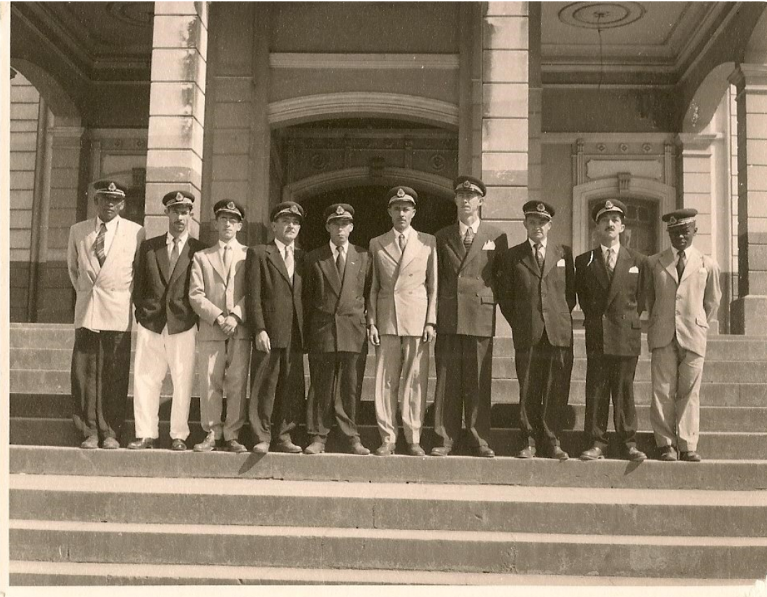
Figura 27: Funcionários da Estrada de Ferro Goiás frente ao prédio da estação (maquinistas). (Código: 5.188)
