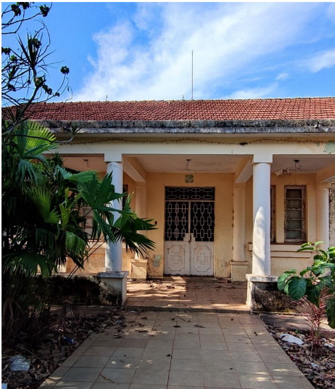
Figura 7: Atual situação do antigo hospital da Goiás. Fonte: Acervo pessoal.
