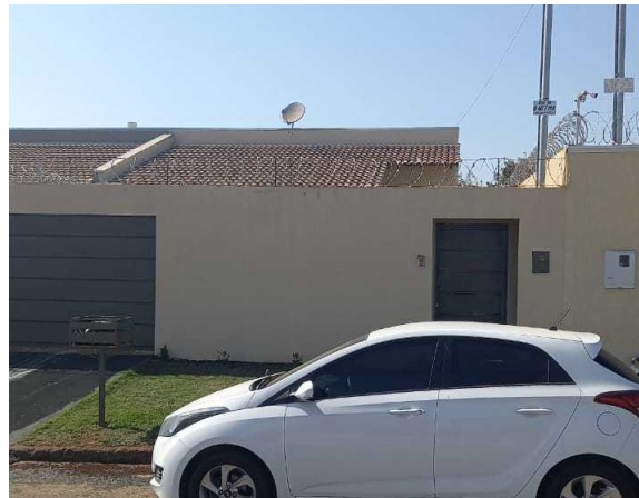
Figura 10 – Fachada do local de instalação do cliente A
