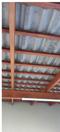
Figura 7 – Estrutura do telhado do cliente A
