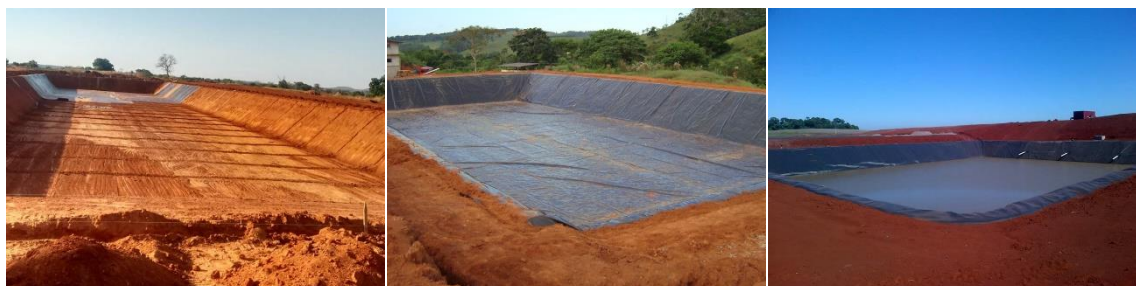
Figura 38 – Aplicação de manta impermeabilizante em reservatórios de chorume
