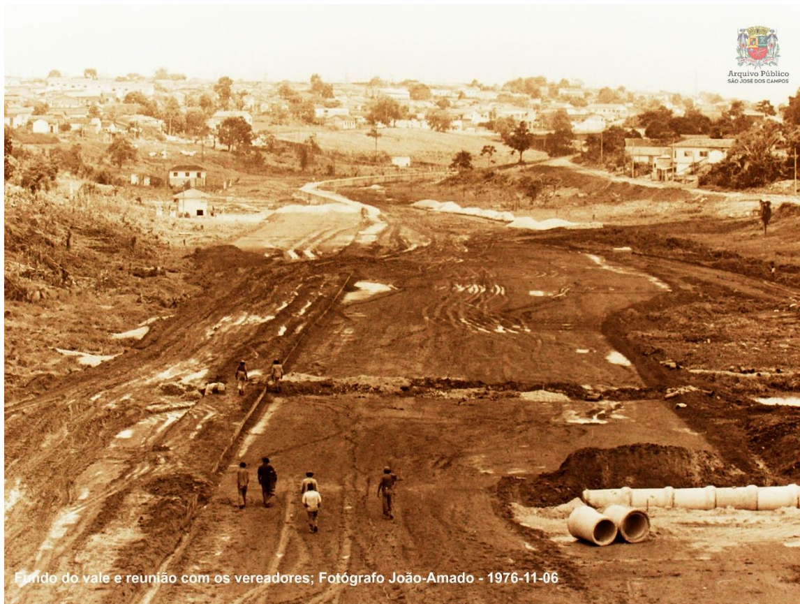
Figura 06 – Obra de abertura da Avenida Fundo do Vale
