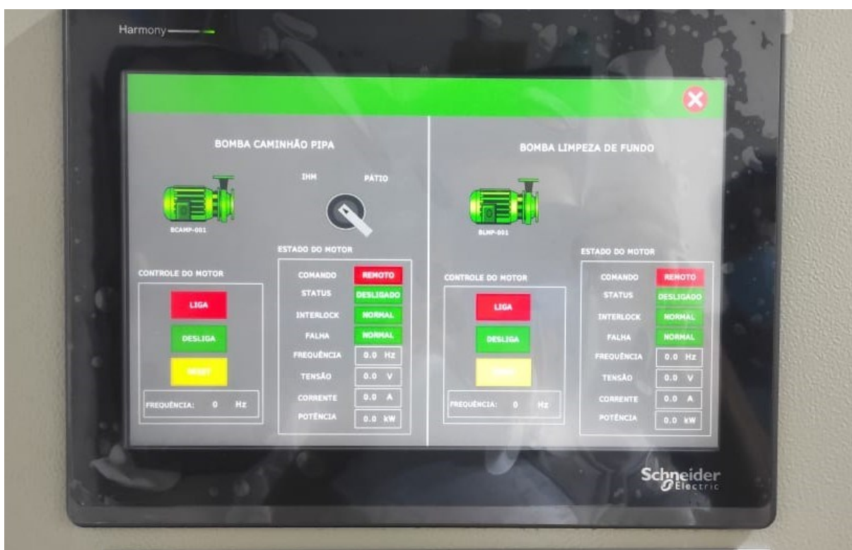
Figura 43: POP-UP das bombas do caminhão pipa e limpeza de fundo.
