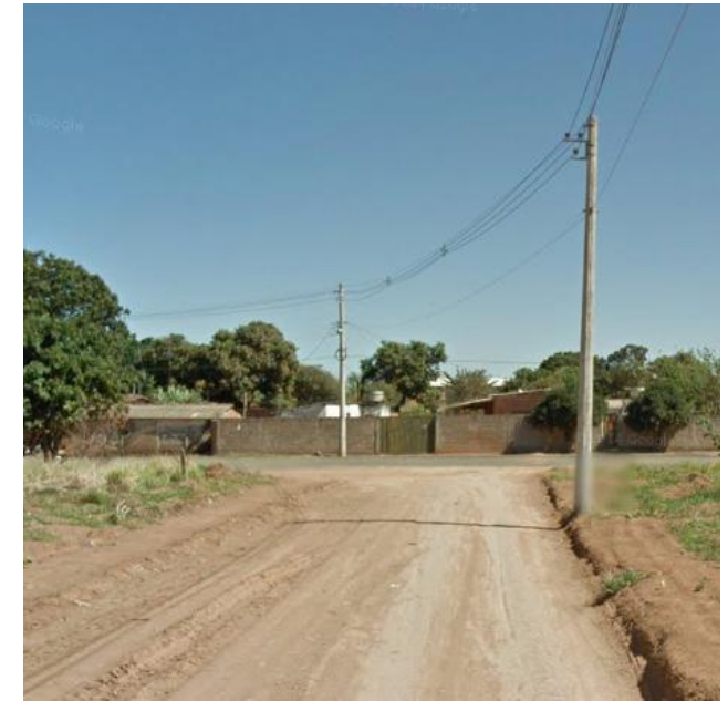
FIGURA 14 - Via sem pavimentação em bairro da área 03
