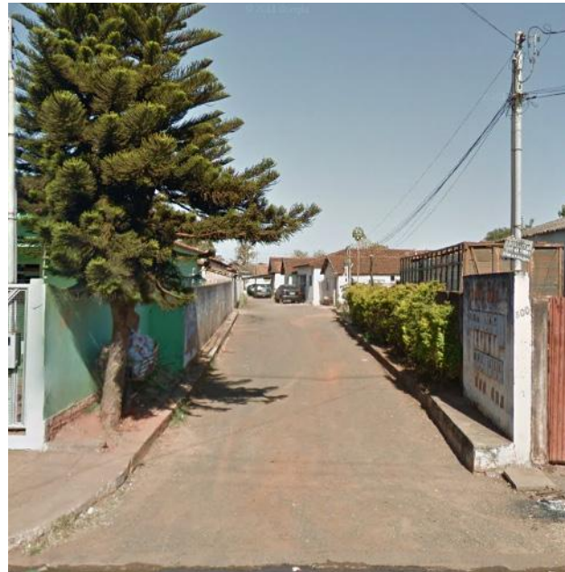
FIGURA 13 - Via sem pavimentação em bairro da área 02
