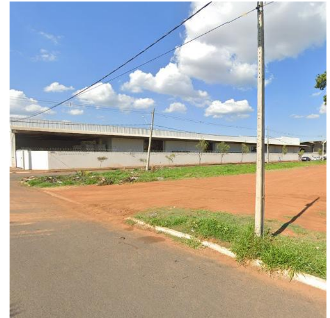
FIGURA 19 - Calçada sem pavimentação em bairro da área 03
