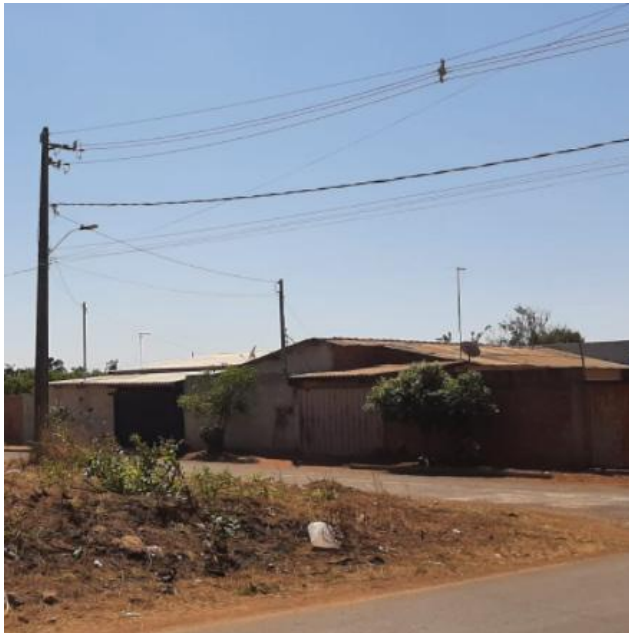
FIGURA 17 - Calçada sem pavimentação em bairro da área 01
