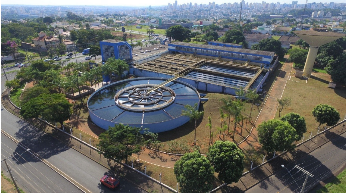
Figura 3 - Estação de Tratamento de Água Bom Jardim.
