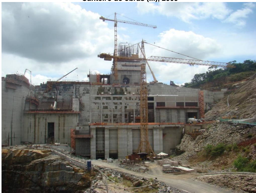
FIGURA 18. Fotografia. Construção da barragem UHE Serra do Facão Canteiro de obras (III), 2009
