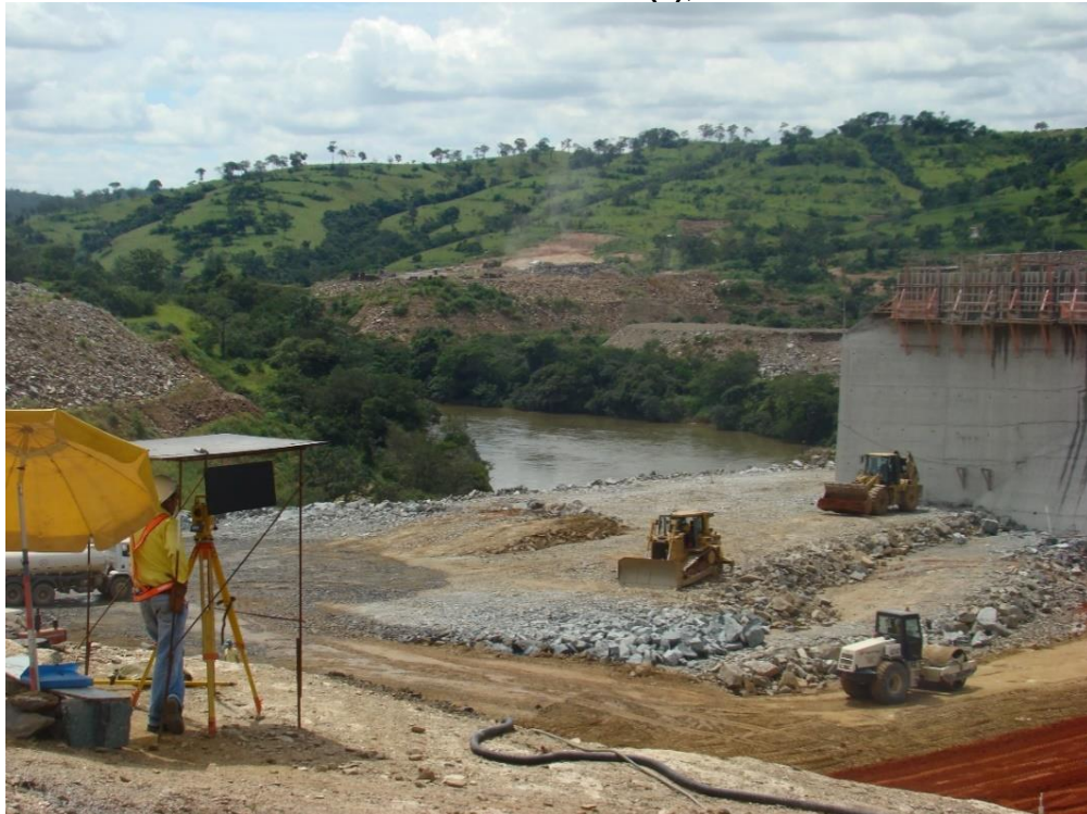
FIGURA 17. Fotografia. Construção da barragem UHE Serra do Facão Canteiro de obras (II), 2009
