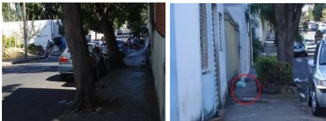
Fíg 04: Barreira na calçada. Fonte: Rodrigues, 2010 Fíg 05: Degrau na calçada. Fonte: Rodrigues, 2010
