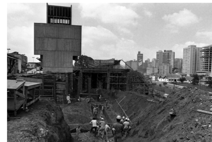
FIGURA 36 - OBRAS DO CENTRO CULTURAL. DISPONÍVEL EM < WWW.CENTROCULTURAL.SP.GOV.BR > ACESSADO EM MAIO DE 2021
