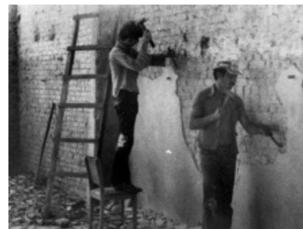
FIGURA 25 - RETIRADA DO REBOCO DAS PAREDES ORIGINAIS DO GALPÃO DE ATIVIDADES GERAIS, ABRIL 1980. DISPONÍVEL EM <A href="https://vitruvius.com.br/revistas/read/minhacidade/08.093/1897">HTTPS://VITRUVIUS.COM.BR/REVISTAS/READ/MINHACIDADE/08.093/1897> ACESSADO EM MAIO DE 2021
