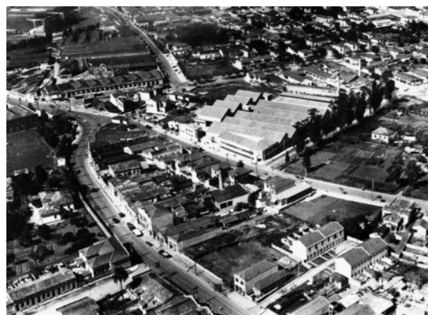
FIGURA 23 - VISTA AÉREA GERAL DA FÁBRICA DA POMPÉIA ANTES DA REFORMA - FOTO PETER SHEIER. DISPONÍVEL EM <A href="https://vitruvius.com.br/revistas/read/minhacidade/08.093/1897">HTTPS://VITRUVIUS.COM.BR/REVISTAS/READ/MINHACIDADE/08.093/1897> ACESSADO EM MAIO DE 2021
