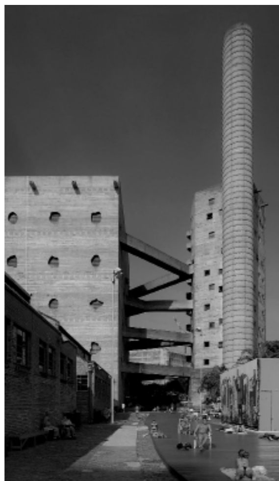
FIGURA 26 - OS TRÊS VOLUMES DO SESC POMPEIA E O DECK SOLARIUM, IMPORTANTE ESPAÇO DE LAZER PARA OS MORADORES DO BAIRRO QUE O UTILIZAM PARA TOMAR SOL. DISPONÍVEL EM <A href="https://www.vivadehora.com.br/pro/arquitetos/sesc-pompeia-lina-bo-bardi/?utm_medium=social&utm_source=pinterest&utm_campaign=&utm_content=> https://www.vivadehora.com.br/pro/arquitetos/sesc-pompeia-lina-bo-bardi/?utm_medium=social&utm_source=pinterest&utm_campaign=&utm_content="> https://www.vivadehora.com.br/pro/arquitetos/sesc-pompeia-lina-bo-bardi/?utm_medium=social&utm_source=pinterest&utm_campaign=&utm_content="> ACESSADO EM MAIO DE 2021
