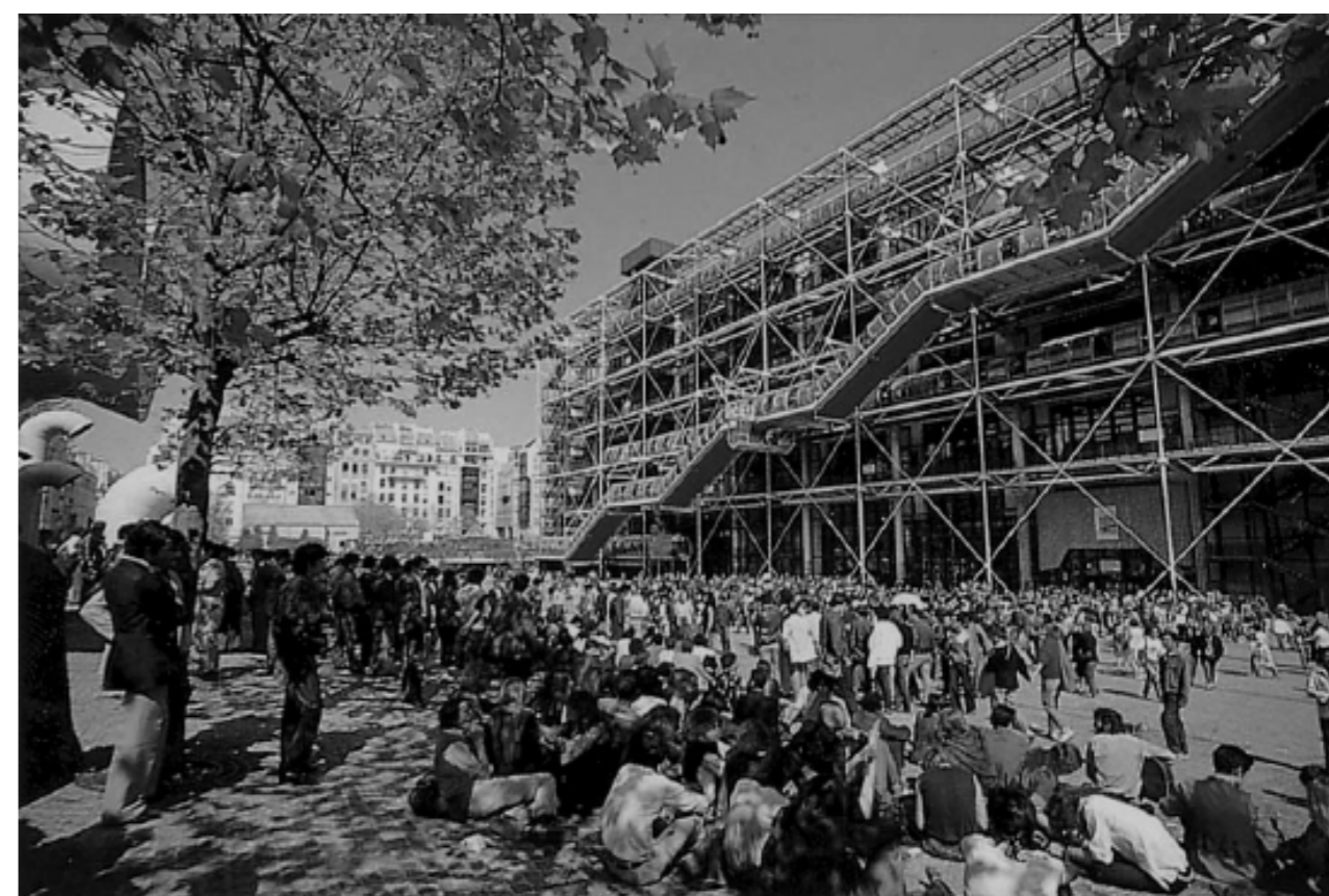
FIGURA 16 - CENTRO GEORGE POMPIDOU E A RELAÇÃO COM O ENTORNO. PARIS, FRANÇA. DISPONÍVEL EM < https://pt.wikiarquitectura.com/constru%C3%A7%C3%A3o/centro-cultural-george-pompidou/# > ACESSADO EM MAIO DE 2021
