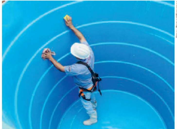
Figura 20: Trabalhador realizando a limpeza de caixa-d'água.
