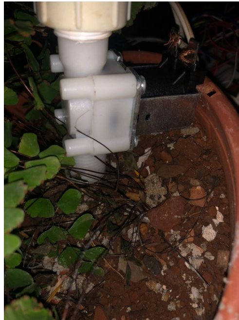
Figura 32 – Válvula solenoide fixada no solo.
