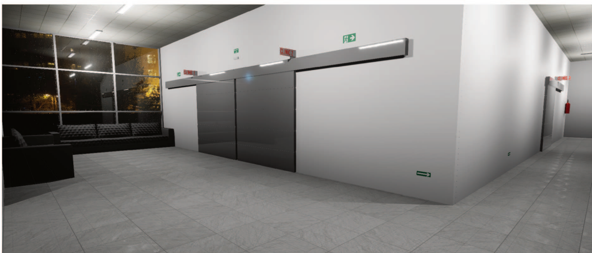
Figura 27 – Sala de espera interna.
