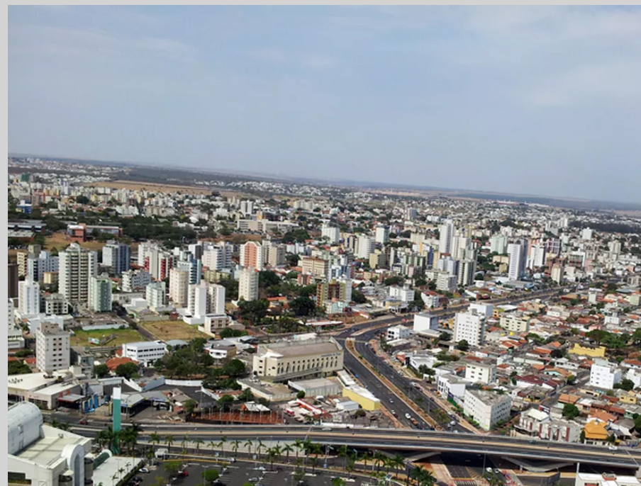
Figura 53- Vista parcial de Uberlândia, com destaque na quantidade de prédios, 2019.
