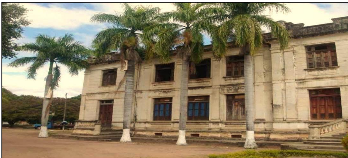
Foto 2: Prédio da Fundação Caio Martins (FUCAM)-Buritizeiro-MG
