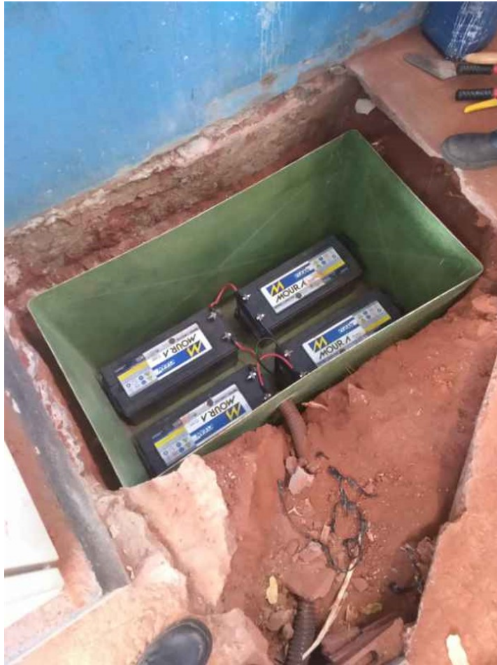
Figura 10 - Instalação de Banco de bateria enterrado
