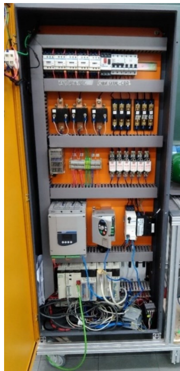
Figura 36 – Painel de comando da esteira transportadora.
