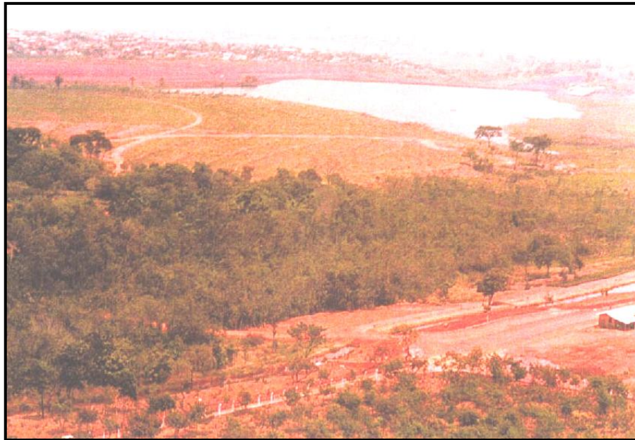
Figura 22 – Parque do Sabiá (1979) – Início das obras Fonte: Colesanti, 1994.
