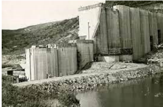
Figura 02. Construção da Barragem da Pedra
