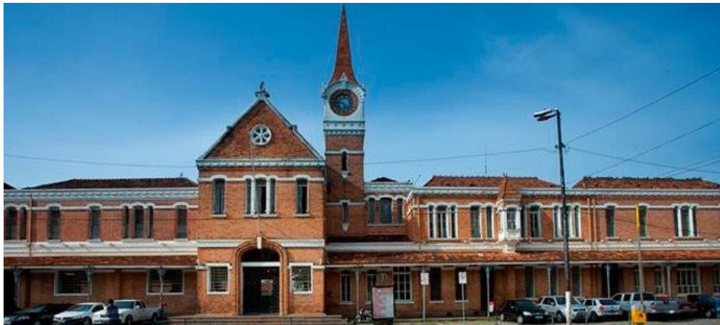
Figura 01. Casa da Cultura – Antiga Estação Ferroviária (2017)
