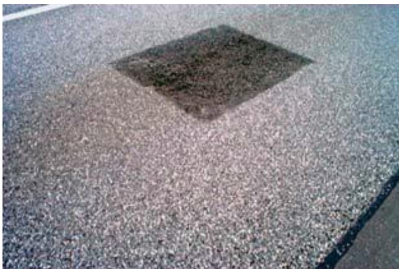
Figura 13 — Remendo
