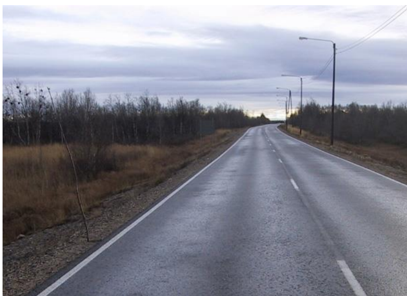
Figura 7 — Afundamento de consolidação das trilhas de roda
