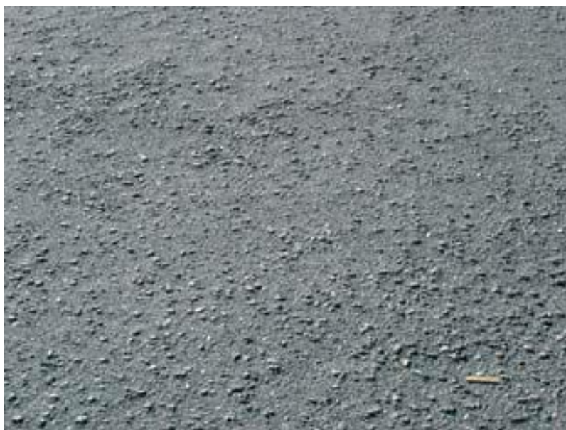
Figura 11 — Desgaste
