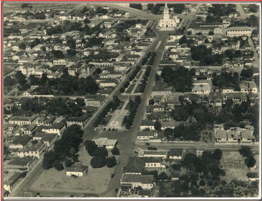
Figura 1 Vista aérea de Araxá-MG (Av. Antônio Carlos)
